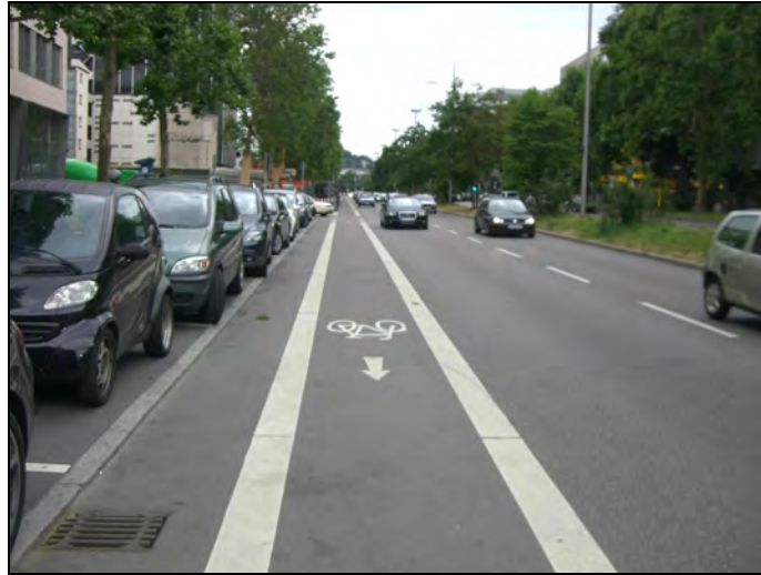
Bild 4-3: Radfahrstreifen mit Sicherheitsraum zu parkenden Kfz (Stuttgart)
