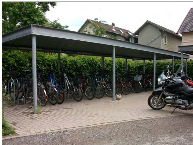
Bild 7-15: Abstellanlagen Nordseite Krankenhaus
