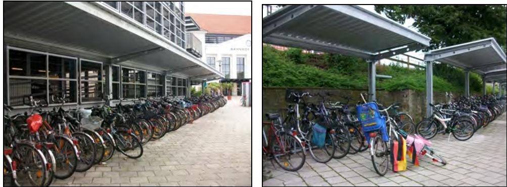
Bild 7-19: Abstellanlagen auf dem Bahnhofsvorplatz (links nördlich, rechts südlich)
