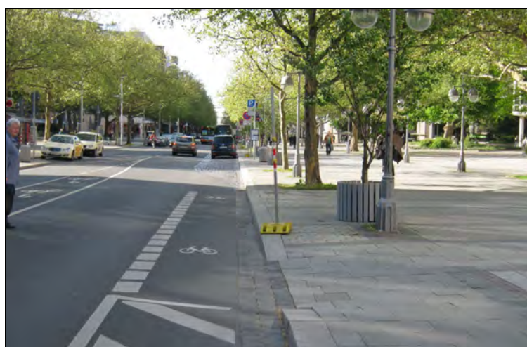
Bild 4-13: Übergang auf die Fahrbahn mit Hilfe einer Bordabsenkung (Hannover)
