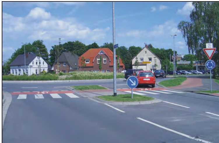
Bild 4-16: Führung des Radverkehrs im Zweirichtungsverkehr an einem Kreisverkehrsplatz (Varel)
