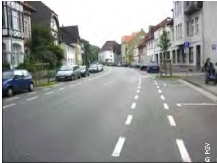
Bild 4-9: Schutzstreifen mit Sicherheitsabstand zu parkenden Kfz (Lemgo)
