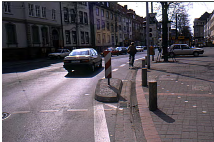
Bild 4-12 Gesichertes Radwegende, in diesem Fall mit Weiterführung als Schutzstreifen (Hannover)
